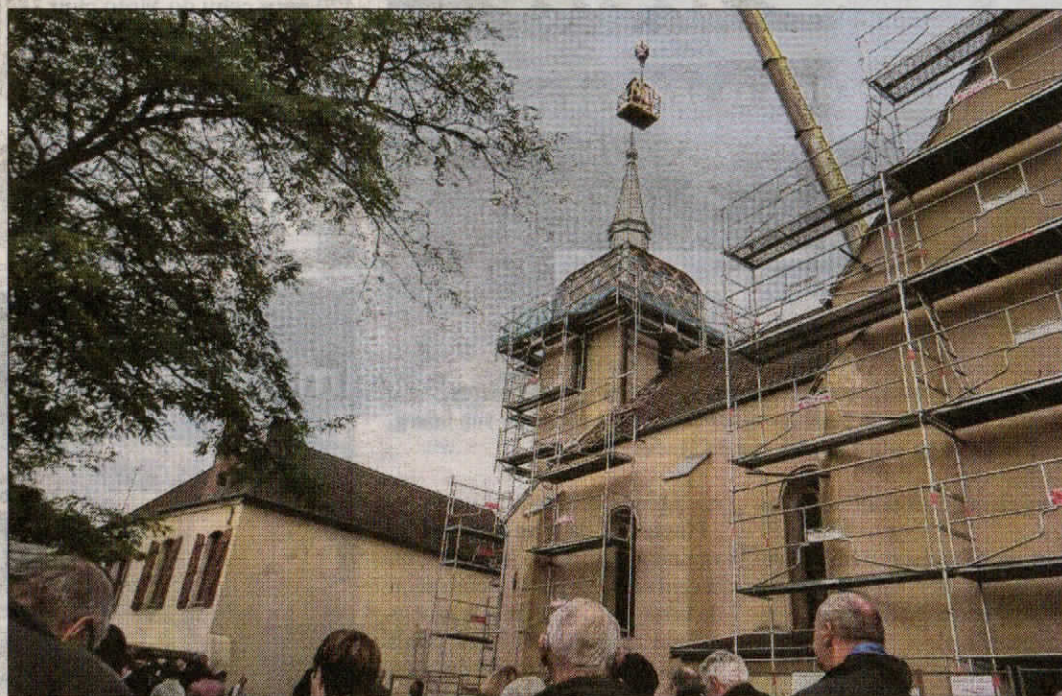
C'est le Père Pierre Bergier, accompagné de l'adjoint et fils de Nadine Daguët, qui ont procédé, à bord d'une nacelle, à l'installation du nouveau coq à la cime du clocher rénové. Photo ER/Maxime CHEVRIER
