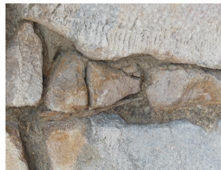
Les joints comblés par de la pierraille sont trop détériorés pour s'opposer à la pénétration de l'eau.
