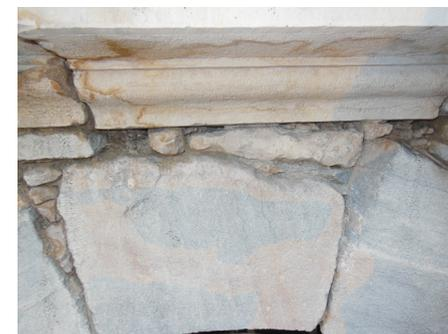
La clef de l'arc a glissé entraînant la déformation de l'armature qui maintenait le vitrail. Ce dernier se déforme. Les verres se dessertissent de leur plomb.
