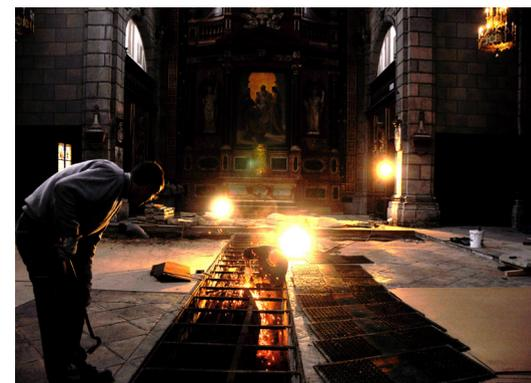
Un nouveau chauffage à air brassé, installé par l'entreprise EIMI, remplace celui de 1930. Par soufflage et aspiration, l'air humide est brassé et la température peut monter en dix minutes de 8° à 16°C.
