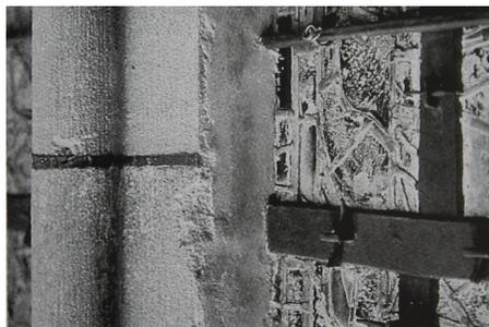
Fixation d'une barlotière horizontale dans la maçonnerie.
